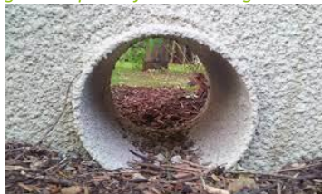
Aménagements d'ouvertures en pied de mur ou muret
