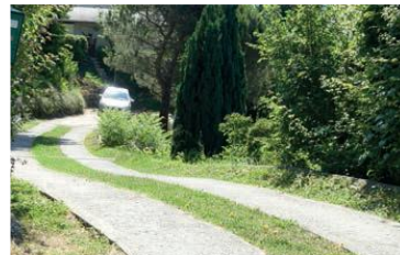
Bandes de roulement en béton, enherbement central
